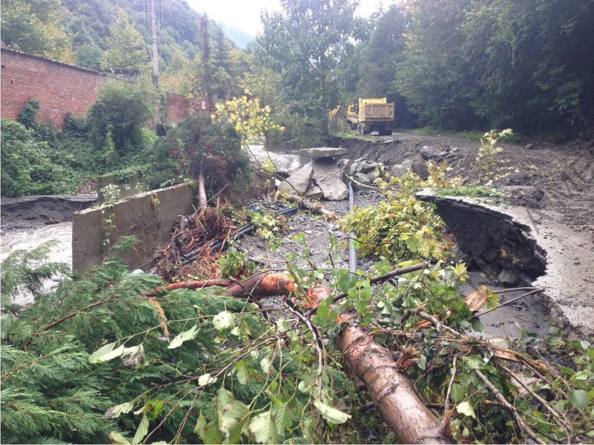
Şekil EK 1.2. 29-30 Eylül 2015 tarihleri arasında kısa sürede meydana gelen şiddetli yağış sonucu oluşan taşkında Kurtköy Deresi yatağının daraltılması kaynaklı taşkın hasarı
