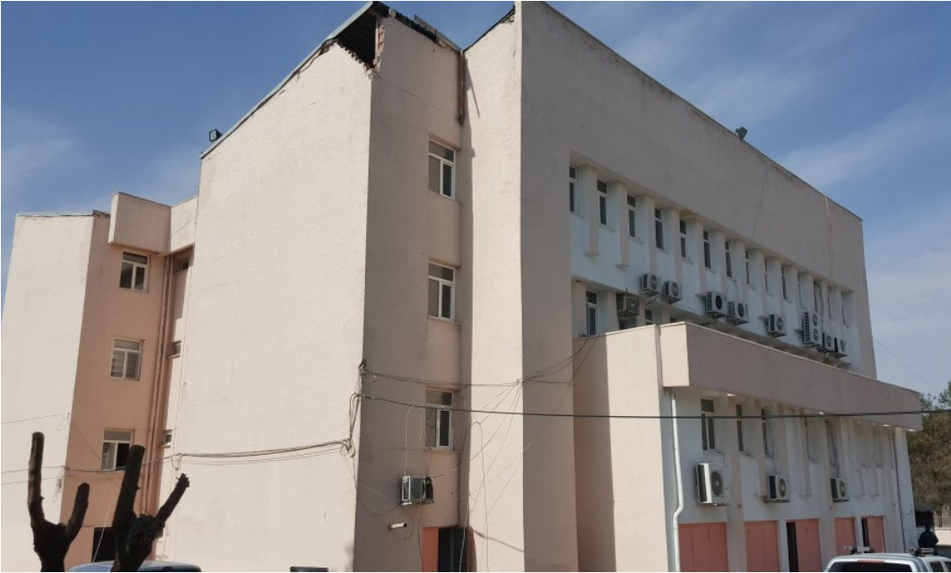
Şekil 17. Yapının arka cephesinde mimari eleman olarak düzenlenen alın kirişi
