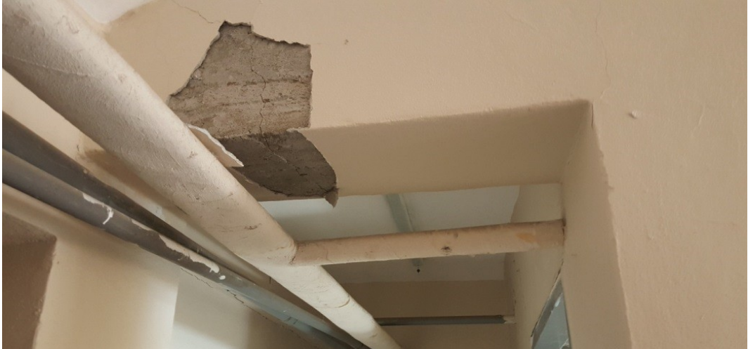
Şekil 10. Perde ile kolon arasındaki kısa kirişte kayma çatlağı
