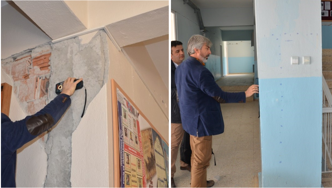
Şekil 15. Betonarme kolonlarda el scanner ı ile donatı tespiti
