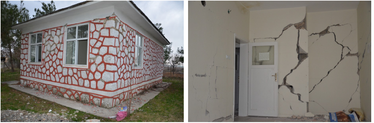
Şekil 35. Dış duvarlarda düzlemi dışına hareket ve büyük çatlaklar, briket bölme duvarlarında ayrılmalar gözlenmektedir.
