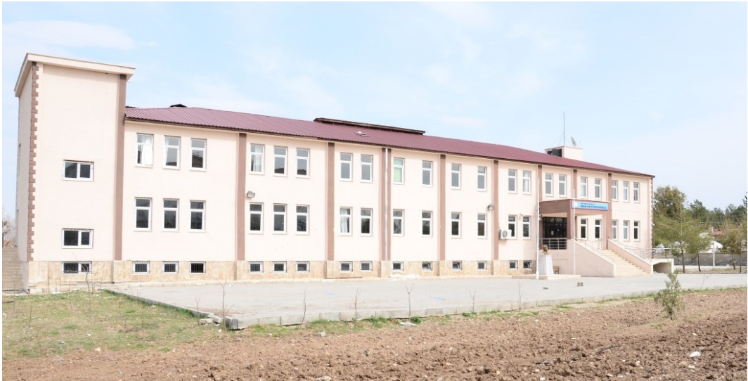
Şekil 19. Samsat Anadolu İmam Hatip Ortaokulu ön cepheden görünüm
