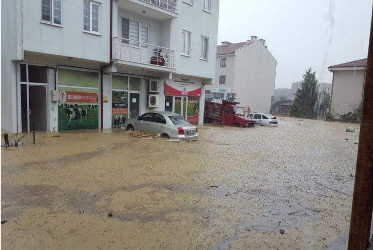
Şekil 10- İlçe merkezinde hasar gören ticari yapılar ve vasıtalar
