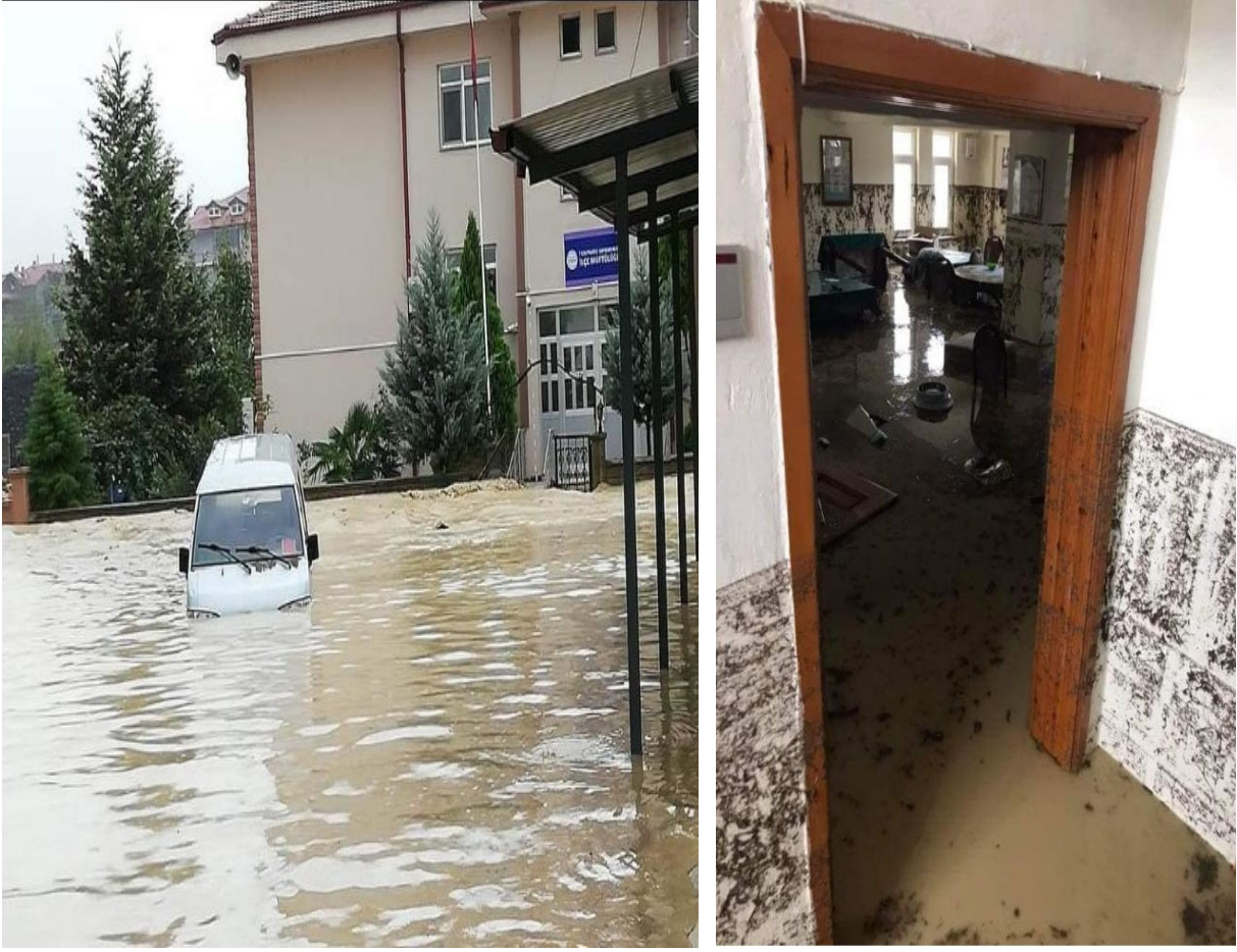
Şekil 14- Taşkına maruz kalan kamu binaları ve su seviyesi
