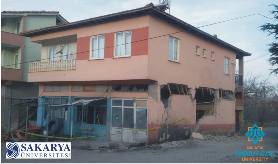
Foto 4. Malatya'nın Doğanyol ilçesi Gökçe beldesinde gözlenen 24 Ocak 2020 Sivrice-Doğanyol depremi kaynaklı bina hasarı.
